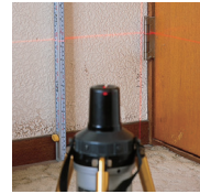
柱の傾斜計測
