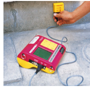
基礎の配筋調査
